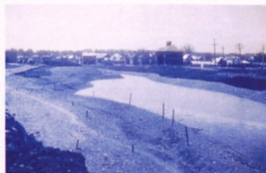
写真5 1890年代、建設中のリバーウェイ。
