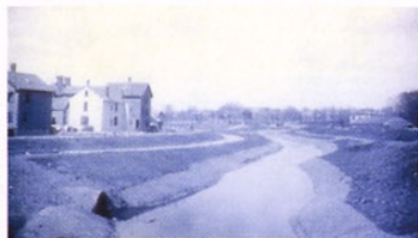
写真3 1890年代、建設中のリバーウェイ。
